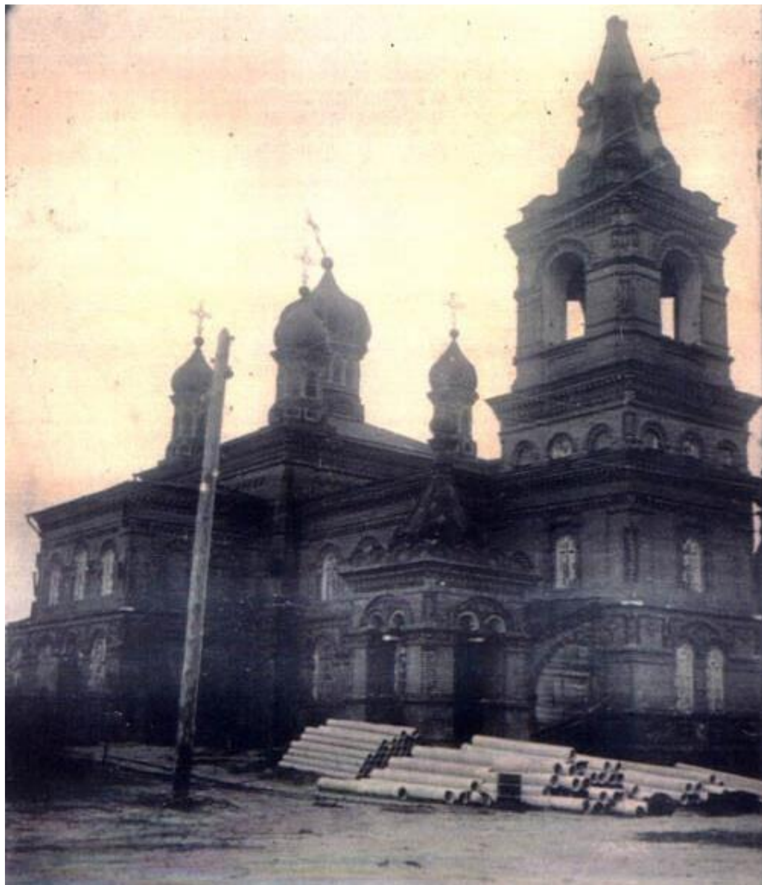
Никольская церковь постройки 1912 года
